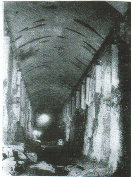
Fig. 7. Betongewelf in een uitgebroken schacht.
