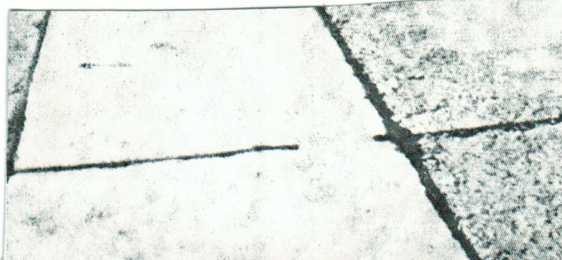
Fig. 4. Pekelschade aan een 1 jaar oude autoweg. Het zoute water bleef aan de rand liggen t.g.v. de aldaar opgehoopte sneeuw.
