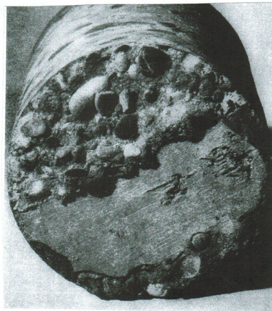
Fig. 4. Deze geboorde proefkern laat het stevige verband zien tussen het wegdekbeton en de onderbouw van ribben.
