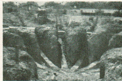
Fig. 9. De ondergrondse trekbanden in het middengedeelte.
