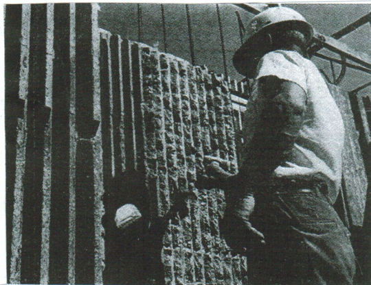
Fig. 5. Het groefvormige brute aanzien wordt verkregen door het wegslaan van de trapeziumtoppen met de hamer.
