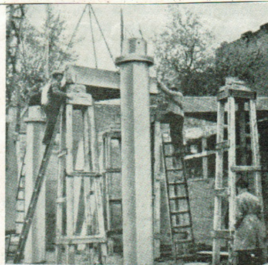
Fig. 9. Oplegging der vloerelementen met tijdelijke ondersteuning der tussenknooppunten.
